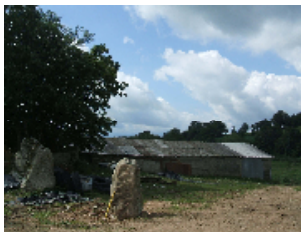
Les ruines de la ferme des Mollières
